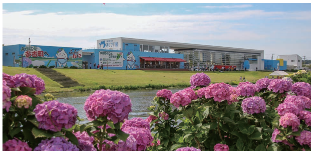
道の駅多古、浄化槽改修工事予定
