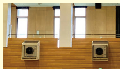
避難所になる体育館のエアコン整備
